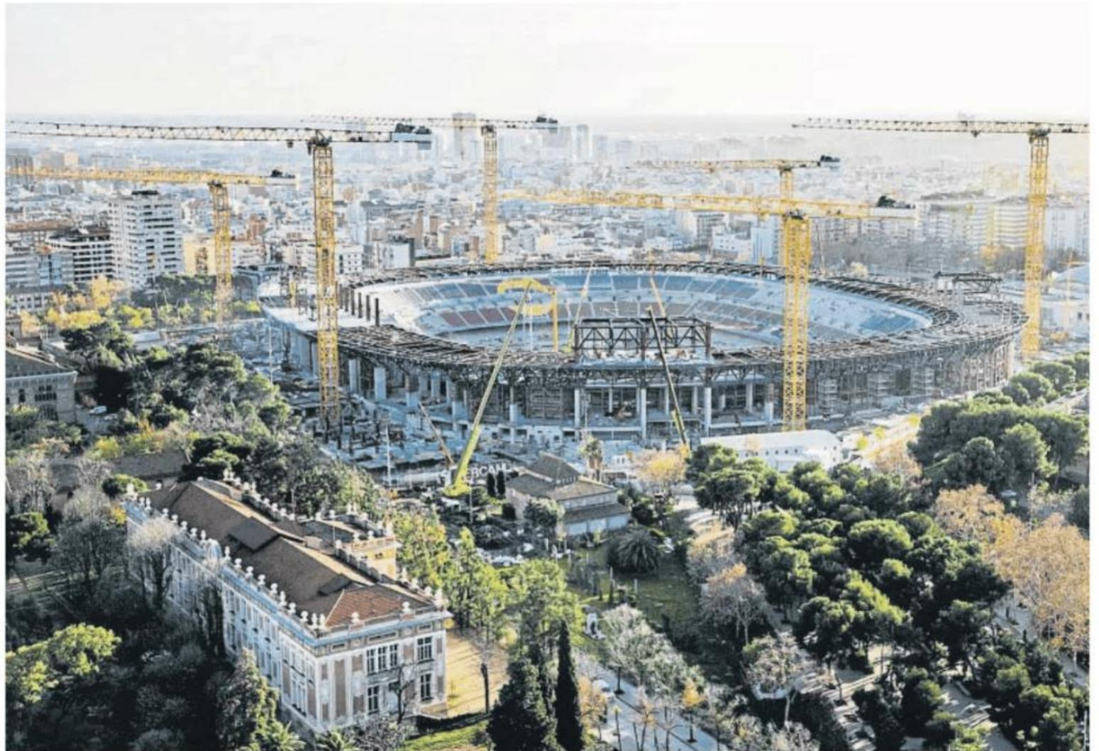
Imagen de las obras del Spotify Camp Nou con los operarios de Limak trabajando en la estructura de la tercera gradería y el anillo VIP
